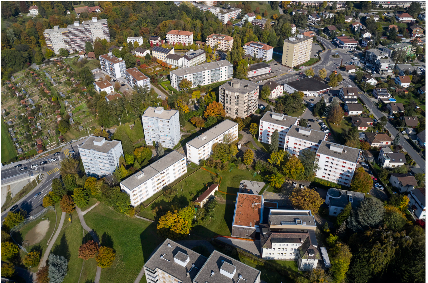
Flugaufnahme der Cité Bellevue mit den sieben Wohngebäuden (Foto Alain Kilar) Vue aérienne de la Cité Bellevue avec les sept immeubles d'habitation (photo Alain Kilar)
